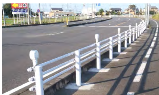
▲令和3年9月 県道川越北環状線 平塚橋東
