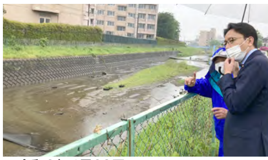
▲令和3年4月29日 倉ヶ谷戸堰水利組合の皆様より南小畔川浚渫の要望
