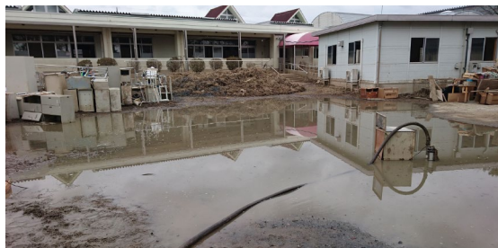
▲施設の被害状況(昨年10月)
