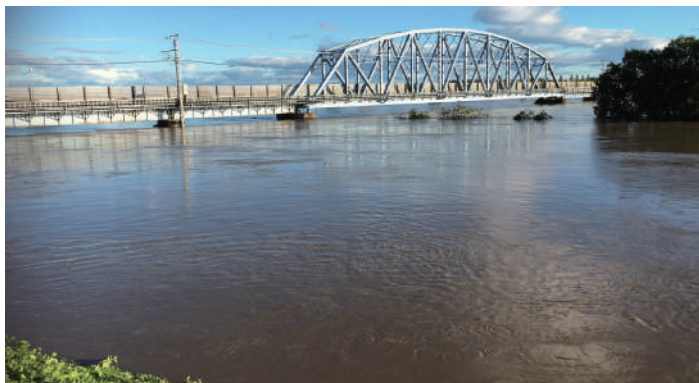
台風19号により増水する荒川（JR 川越線荒川橋梁付近）
